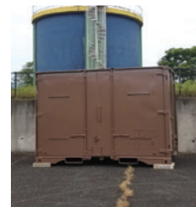
▲町上水道第4水源地
