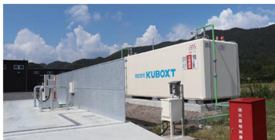
▲燃料(軽油)を貯蔵する「コンボルト型タンク」
