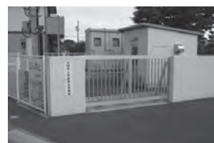
▲第5水源地／大野地内
