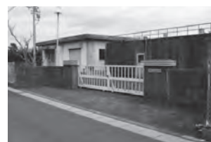
▲第2水源地／古川地内
