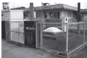
▲第1水源地／寺内地内
