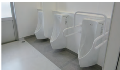
▲改修実施後の小学校屋内運動場トイレ（写真は南小学校屋内運動場）
