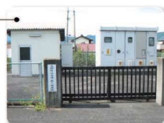
第3水源地(深井戸) Q=3,000m 3 /日
