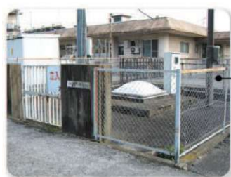
第1水源地(深井戸) Q=1,050m 3 /日
