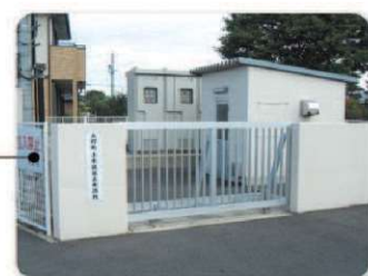
第5水源地(浅井戸) Q=750m 3 /日
