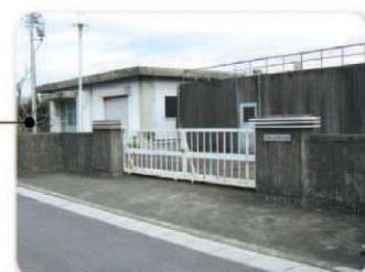
第2水源地(深井戸) Q=3,600m 3 /日
