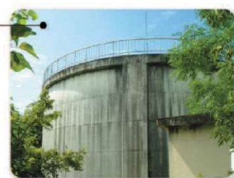
大野配水場 V=2,000m 3 ×1池
