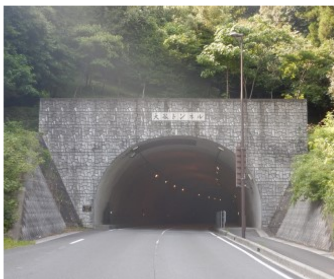
写真 2-2 大谷トンネル終点坑口
