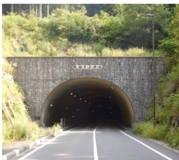
写真 2-1 大谷トンネル起点坑口
