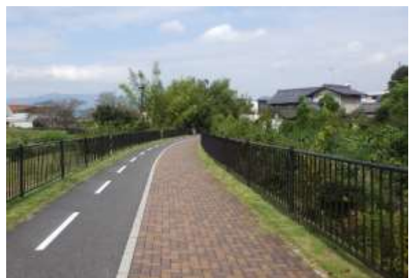
図4-29 廃線敷を活用した自転車歩行者道
