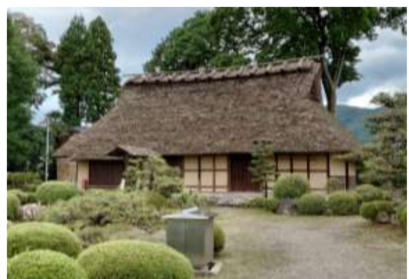
図4-33 重要文化財牧村家住宅
