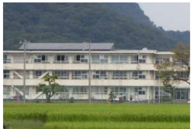
図4-27 太陽光パネル
