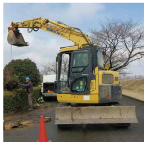
(写真23) 伐根作業
